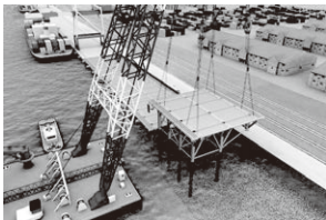
鋼床版・鉄筋を搭載したジャケットを据付イメージ
