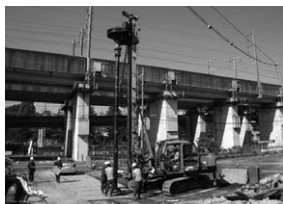
左:小径杭の施工状況 右:低空頭・狭隘地施工
