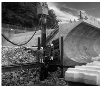
鋼矢板の事例
